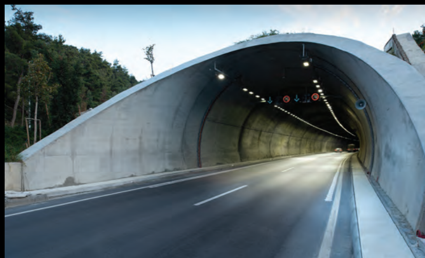
ТУРЦИЯ • ТОННЕЛЬ САБУНДЖУБЕЛИ
